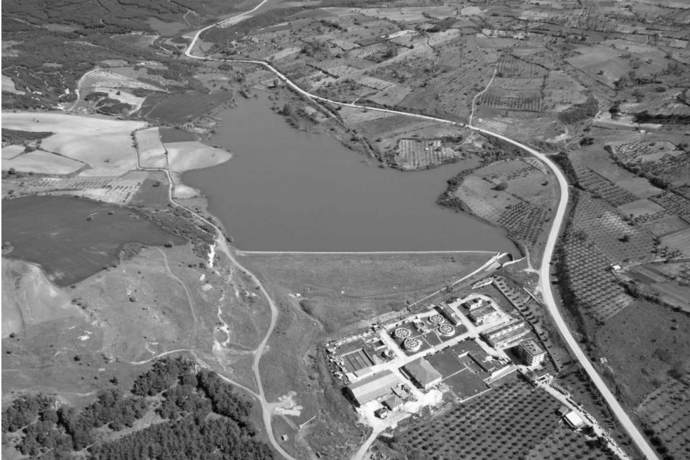
řekil 16. řarky İme Suyu Arıtma Tesisi (7.776 m 3 /gn) (Fiziksel ve Kimyasal Arıtma + Dezenfeksiyon niteleri)
