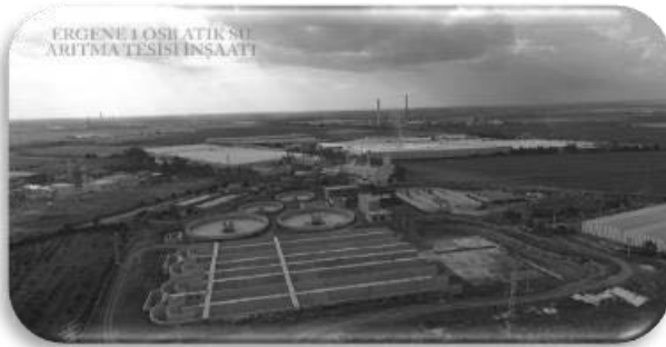
Şekil 12. Türkgücü OSB ve Ergene1 OSB Atıksu Arıtma Tesisleri
