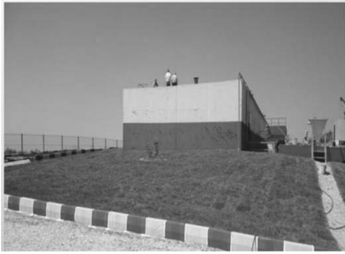
Şekil 5. Mürefte Atıksu Arıtma Tesisi
