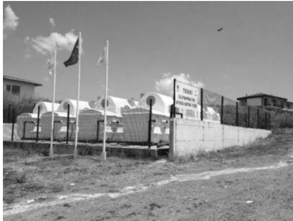
Şekil 4. TOKİ Atıksu Arıtma Tesisi
