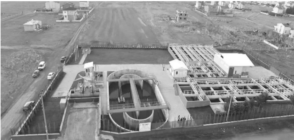
Şekil 3. TESKİ Yeniçiftlik İleri Biyolojik Atıksu Arıtma Tesisi
