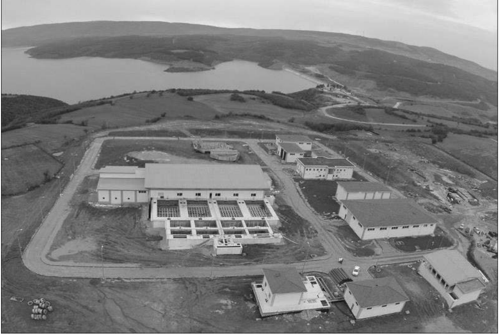
Şekil 19. Çokal İÇme Suyu Arıtma Tesisi (50.000 m 3 /gün)
