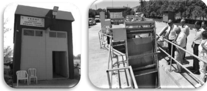
Şekil 10. Şarköy Derin Deniz Deşarjı Tesisi
