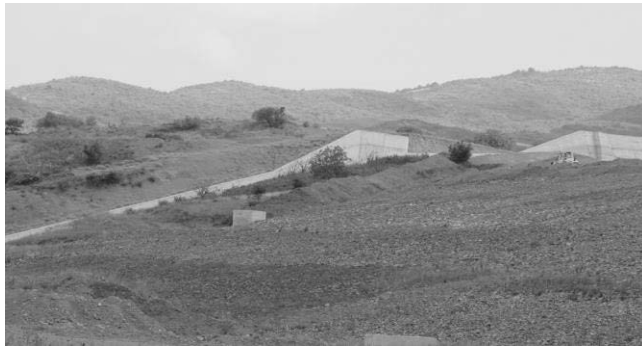
Şekil 4. Yapımı Devam Eden Naipköy Barajı İnşaatı
