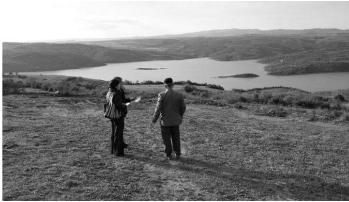
Şekil 6. Çokal Baraj Havzası Denetim Çalışmaları
