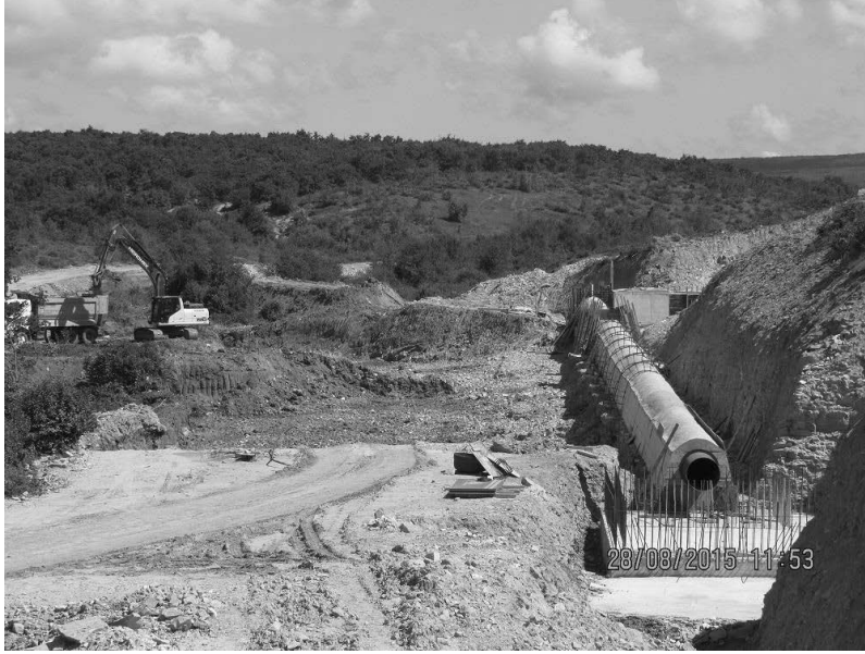
Şekil 2. Yapımı Devam Eden Saray Ayvacık Göleti İnşaatı
