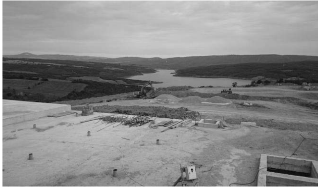
Şekil 3. Yapımı Devam Eden Çokal Barajı İnşaatı
