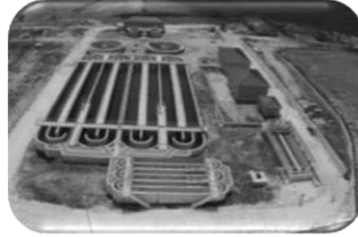
Şekil 8. TESKİ Murath, Çorlu ve Çerkezköy Atıksu Arıtma Tesisleri
