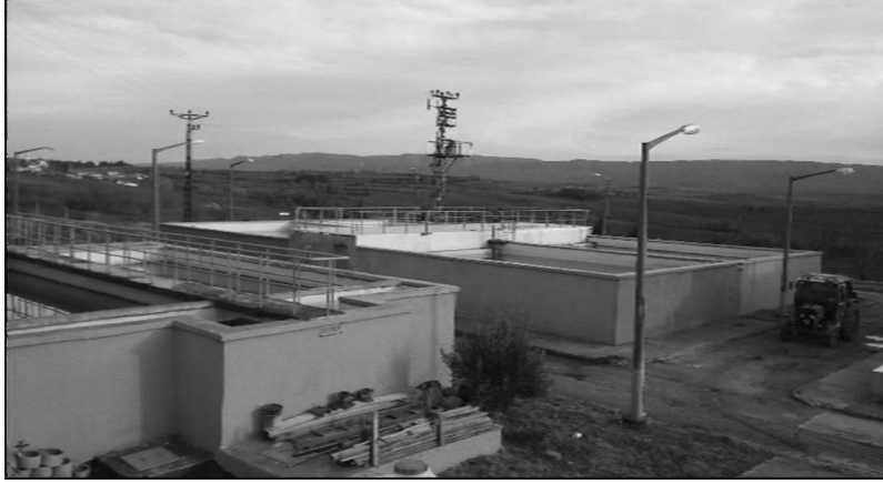
řekil 15. Saęlamtař İme Suyu Arıtma Tesisi (800 m 3 /gün) (Fiz.Arıtma + Dezenfeksiyon)
