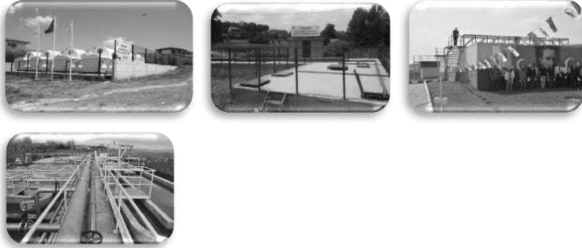
Şekil 5. Yenice, TOKİ, Barbaros ve Mürefte Atıksu Arıtma Tesisleri
