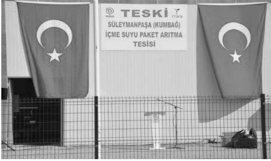
Şekil 13. Kumbağ İçme Suyu Arıtma Tesisi (2.000 m 3 /gün) (Paket Arıtma Sistemi)
