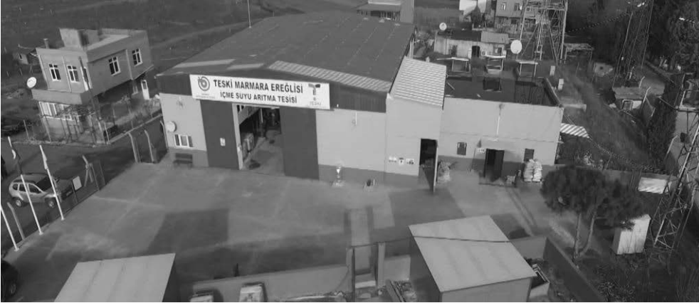
Şekil 3. Marmaraereğlisi İçme Suyu Arıtma Tesisi (10.000 m 3 /gün) (Paket Arıtma Sistemi)
